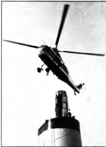
En wire blir festet til skorsteinen.
