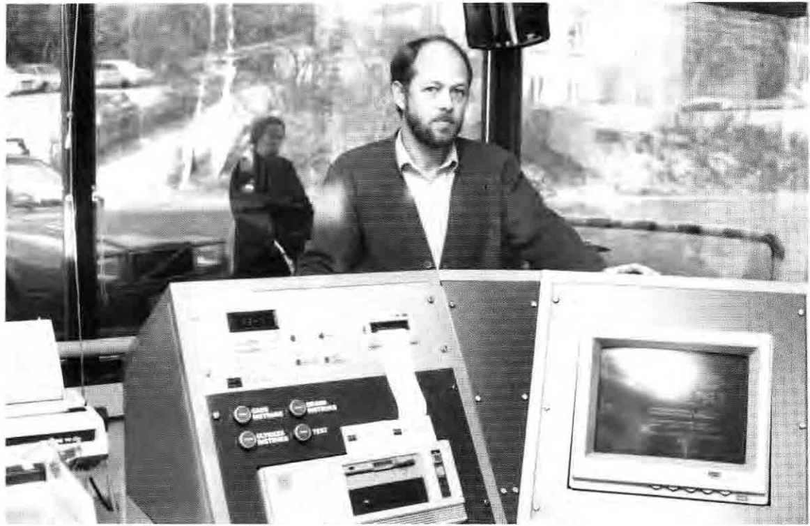
Bjørn Aardahi ved alarmmottagningsentralen i portvakten. En halv million kroner har sentralen, kontrollpulten og opp-pussing kostet.
