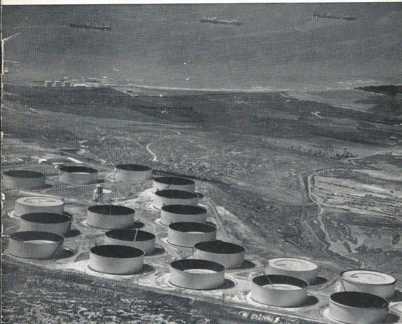
Tankfarmen ved Tapline's Sidon Terminal — Tankene er bygget med tak som flyter på oljen (Se side 4.)
