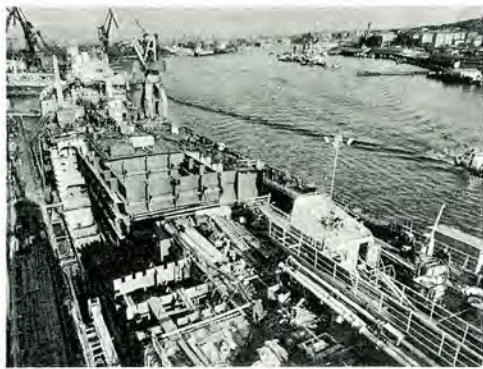
Den nye tankseksjonen er kommet på plass
