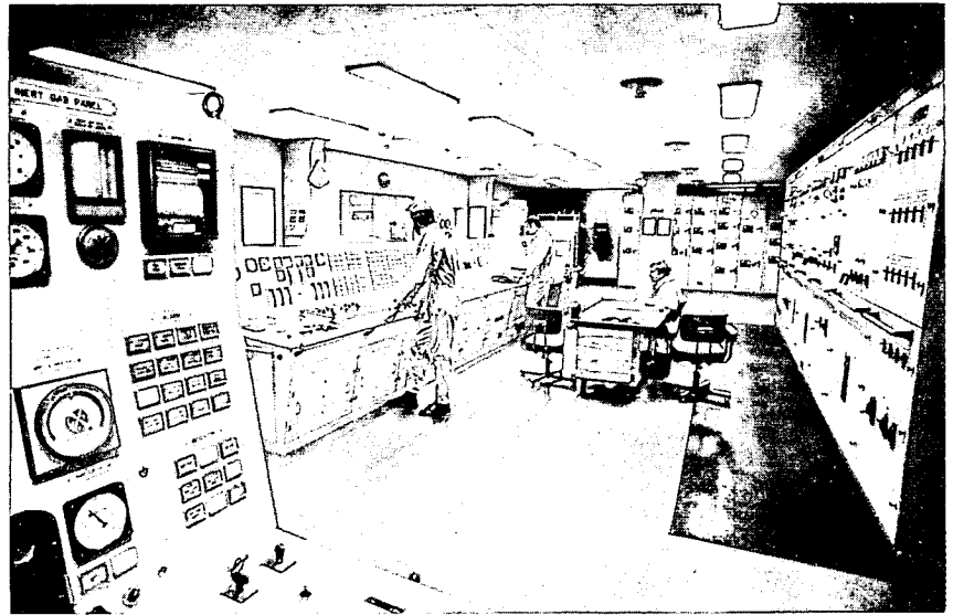
Fra det store kontrollrommet. Ved kontrollpanelet 2. maskinist Per O. Pedersen og 1. maskinist Olav Flaaten overvåket av maskinsjef Leif Gulliksen.
