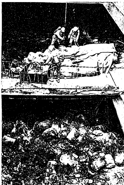
Lossingen av mellomdekket snart ferdig. Underrommet står for tur. (Strb. side)
