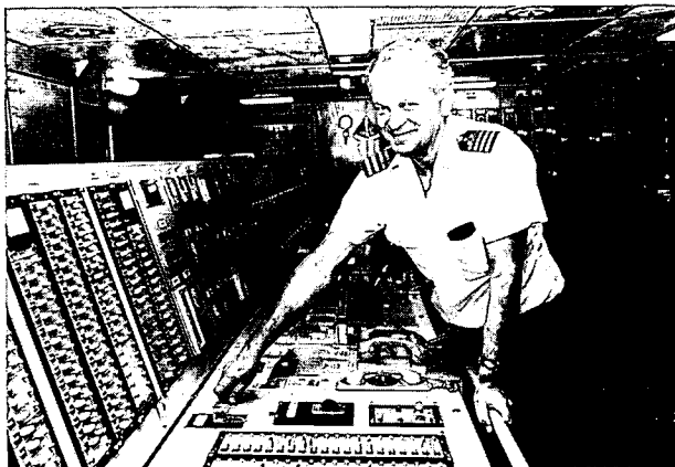
Maskinsjef Bjørn Nilsen fra Stavanger har store krefter å styre, et maskinrom og et kontrollpanel som det står respekt av.
