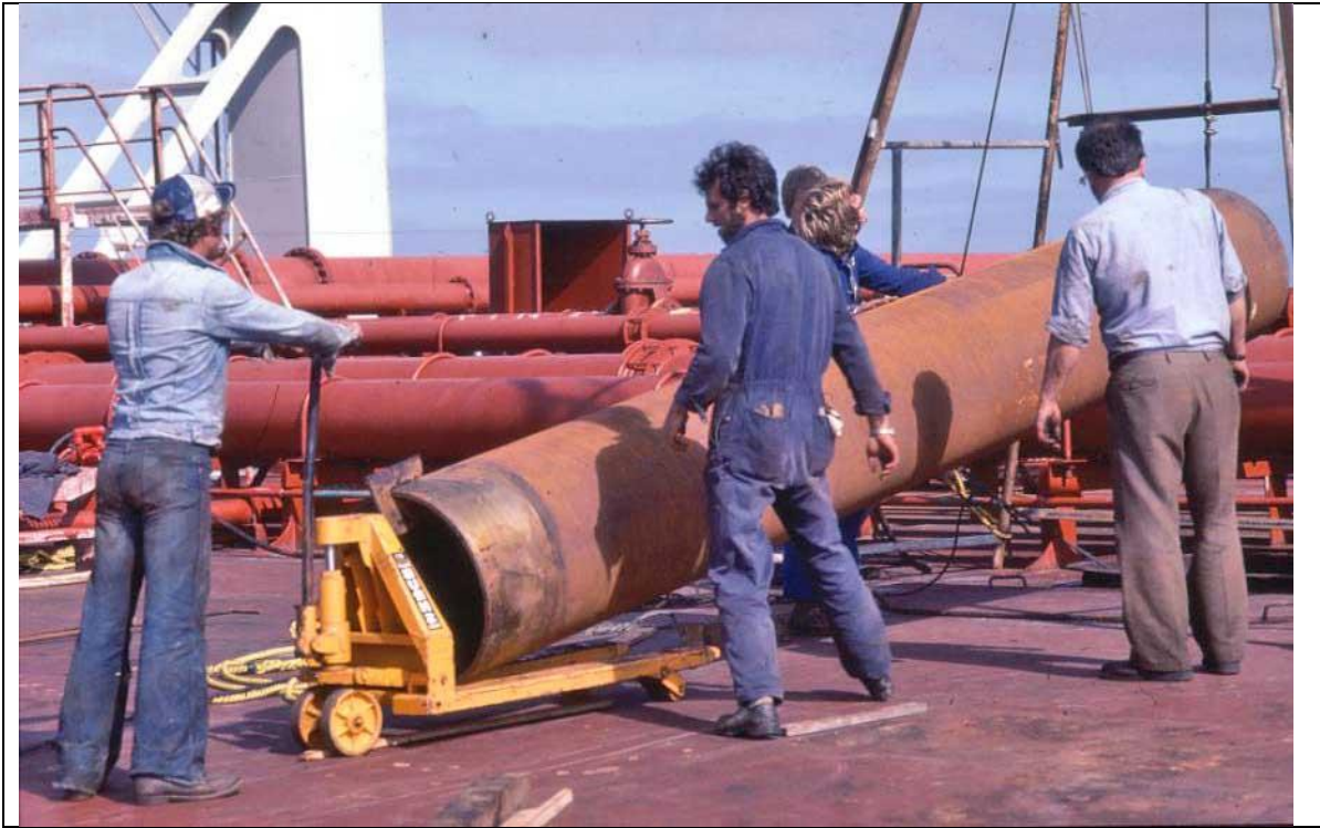
SFJ00119790138106 Jarita, utskifting av rør i tanker (foto: Per Sundfær)
