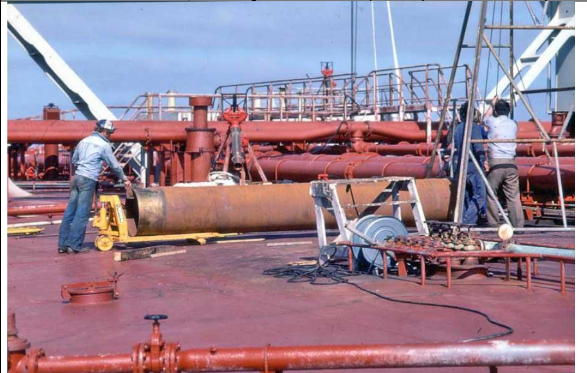
SFJ00119790138105 Jarita, utskifting av rør i tanker (foto: Per Sundfær)
