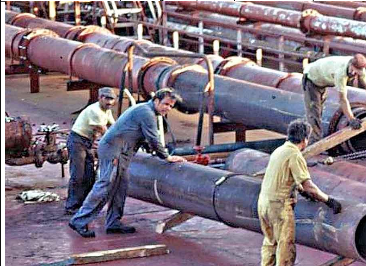
SFJ00119790138103 Jarita, utskifting av rør (foto: Per Sundfær)
