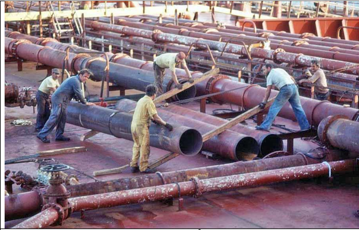
SFJ00119790138102 Jarita, utskifting av rør på dekk (foto: Per Sundfær)
