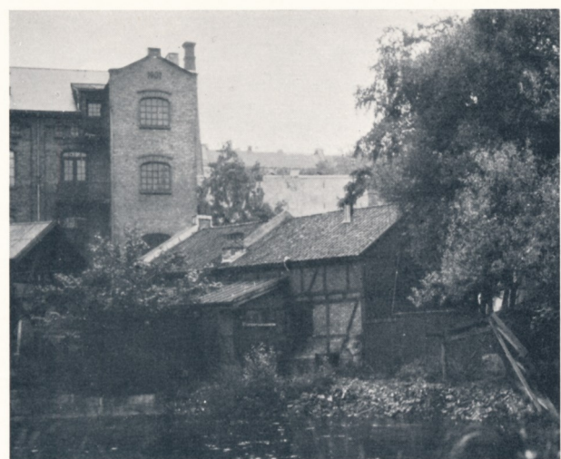
Bindingsverkshus fra det eldste verkstedsanlegg. Står fremdeles på Seilduksfabrikkens eiendom ved Akerselven.
