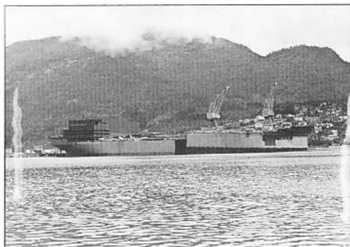
Forskipet buksert til akterskipet og skjøteprosessen skal begynne.
