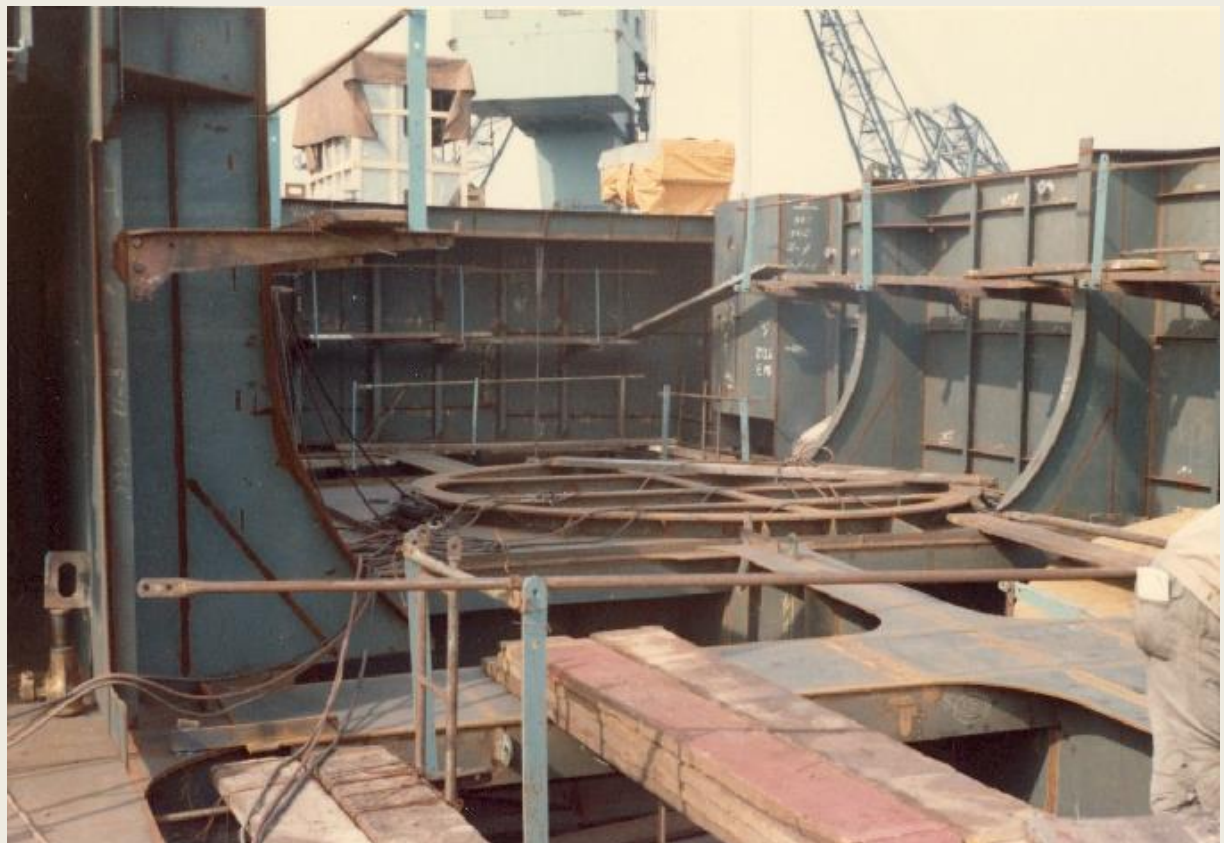
Fundamentet til eksoskjelen.
