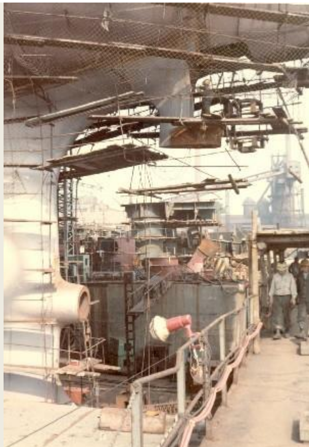
Snart kommer propellakselen og propellen på plass.
