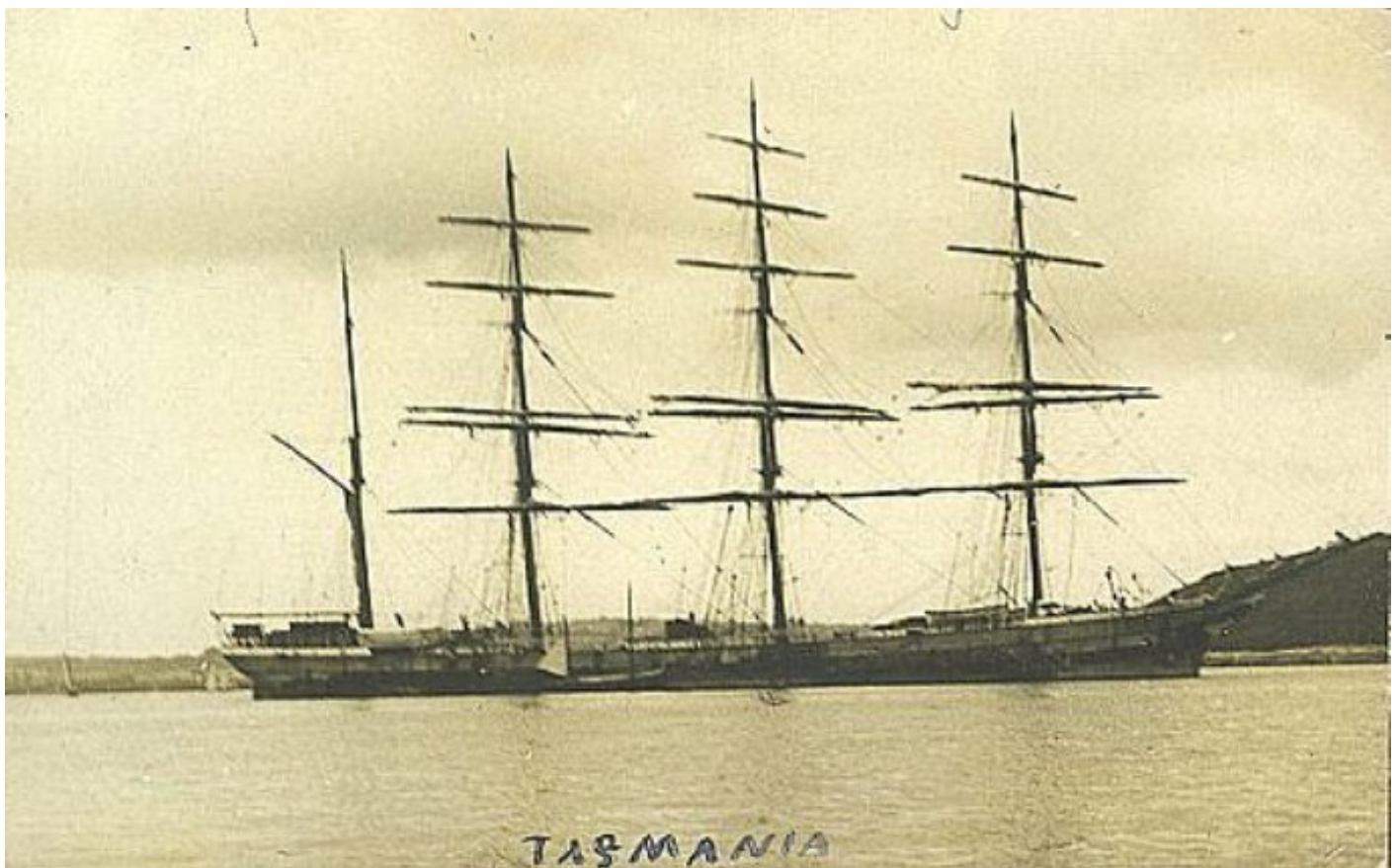
RIS40919140120001 TASMAN som TASMANIA. Bilde via Steinar Norheim.
